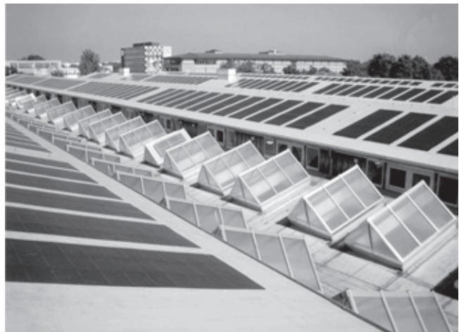
So soll es bald auf möglichst vielen Dächern in München aussehen: Photovoltaikanlage auf dem Dach der Tram-bahn-Werkstätte in der Ständlerstraße.
