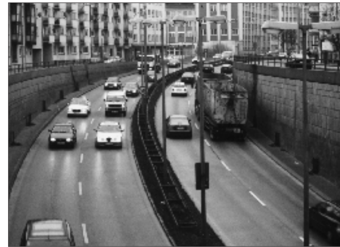
Wer hier wohnt, ist arm dran: 145.000 Kfz am Tag auf der Tegernseer Landstraße
