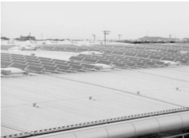
Auf immer immer mehr Dächern entstehen Solaranlagen
