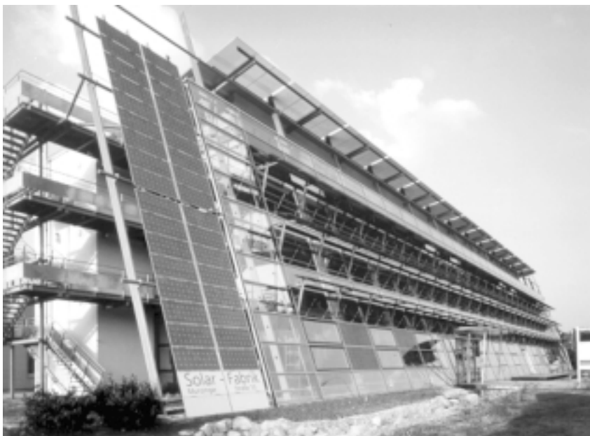
Die Freiburger Solarfabrik
