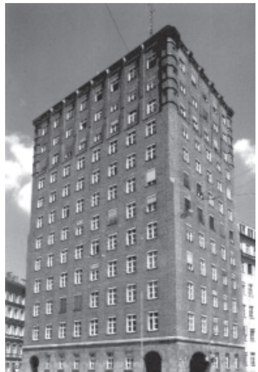
Münchens erstes Hochhaus - mit 45 m ein eher kleineres Exemplar.
