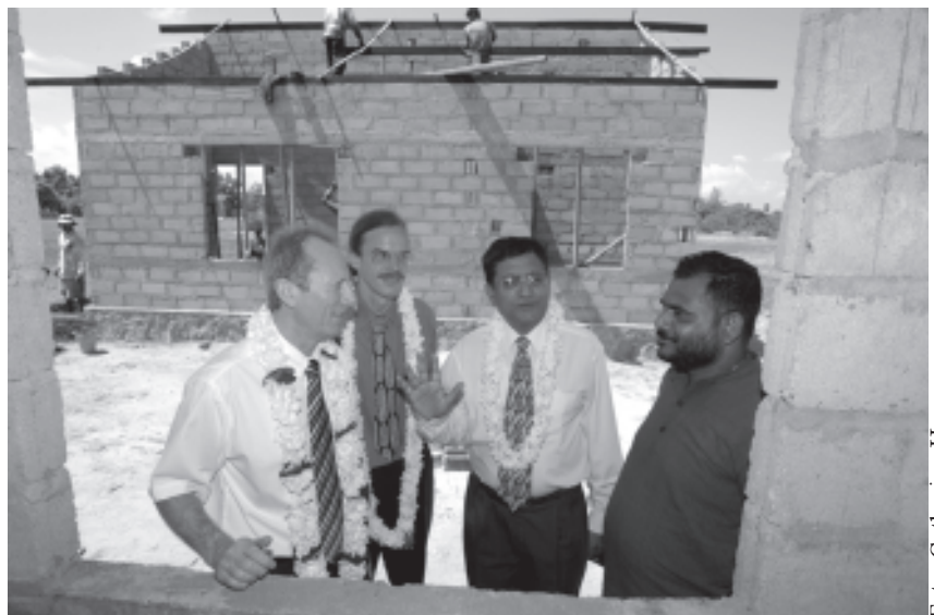
Auf der Baustelle der Munich-Colony
