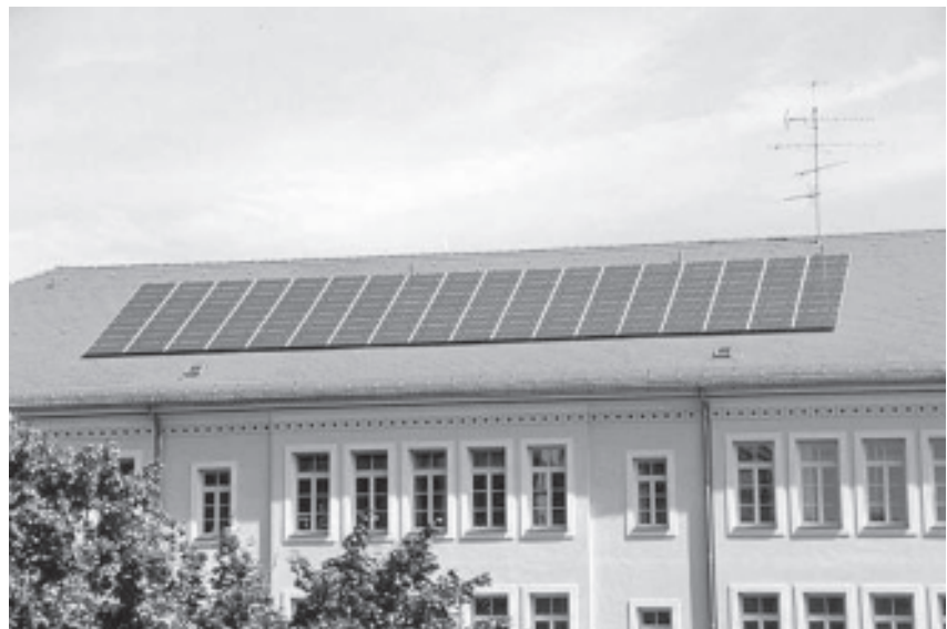
Photovoltaik-Anlage auf dem Dach einer Schule in Haidhausen
